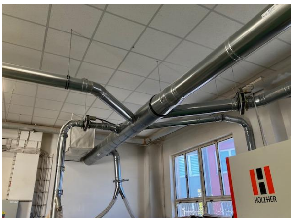
Potrubní rozvody od jednotlivých strojů do filtrační jednotky.
