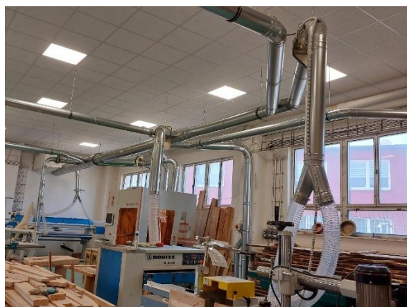
Potrubní rozvody od jednotlivých strojů do filtrační jednotky.
